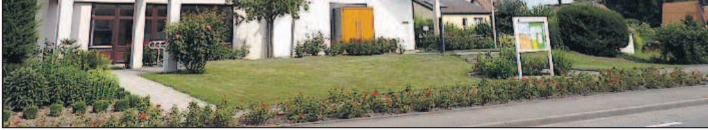
Das Dach der Kirche ist einem Zelt nachempfunden. Es orientiert sich am Bild vom wandernden Gottesvolk.
